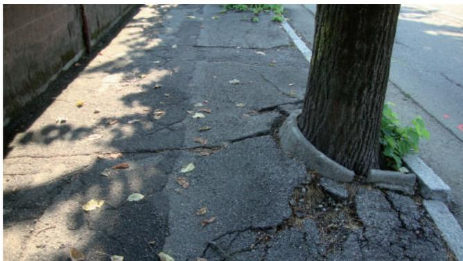
Sollevamento manufatti, a causa delle ridotte quantità di ossigeno nel suolo le radici tendono a risalire. La risoluzione deve prevedere la rimozione dello strato impermeabile all'aria e posa di materiale drenante
