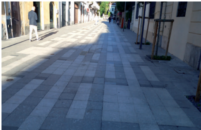
Foto 1 - Lastricato di recente esecuzione in una via di Varese
