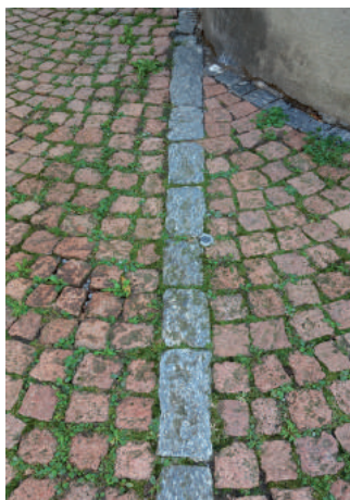
Foto 5 - Arzo strada con fondo in cubetti di porfido rosso di Cuasso al Monte
